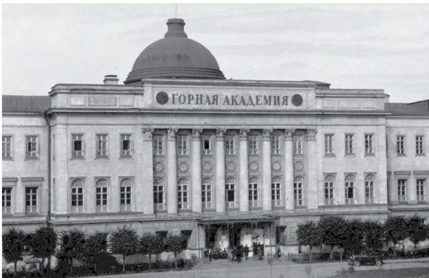
Московский нефтяной институт с 1930 года находился в здании расформированной Московской горной академии по адресу Калужская площадь, дом 6
